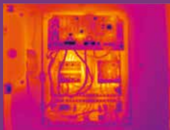
Termografía: 320 x 240 píxeles
