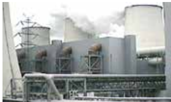
Inspección de aislamiento
