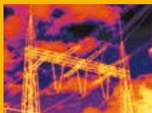
Inspección de cables de alimentación de alta tensión
