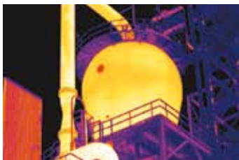
Inspección del aislamiento refractario en un reactor petroquímico
