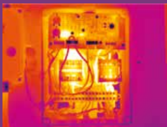
Termografía: 640 x 480 píxeles
